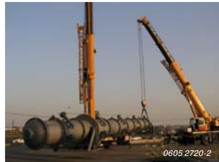
SMR-реактор для производства полистирола
